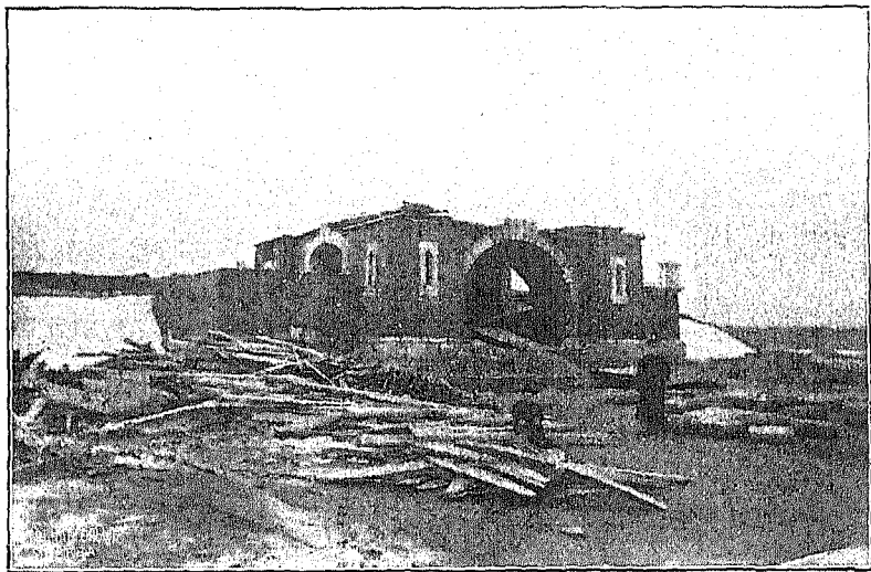
Видъ резервуара весною при началѣ работъ.
