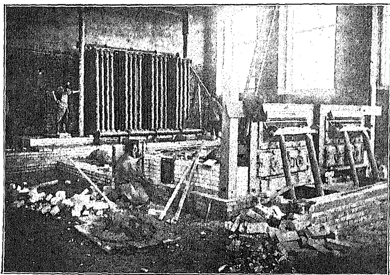
Установка паровыхъ котловъ и экономайзера.
