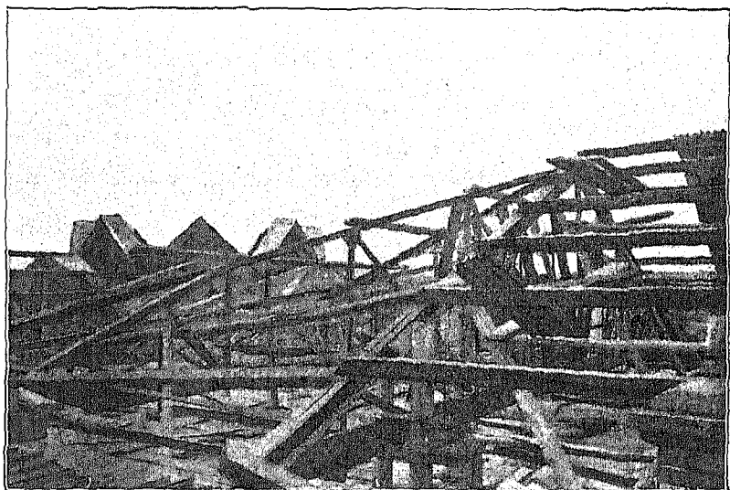
Постановка на зданіи желѣзныхъ стропиль.
