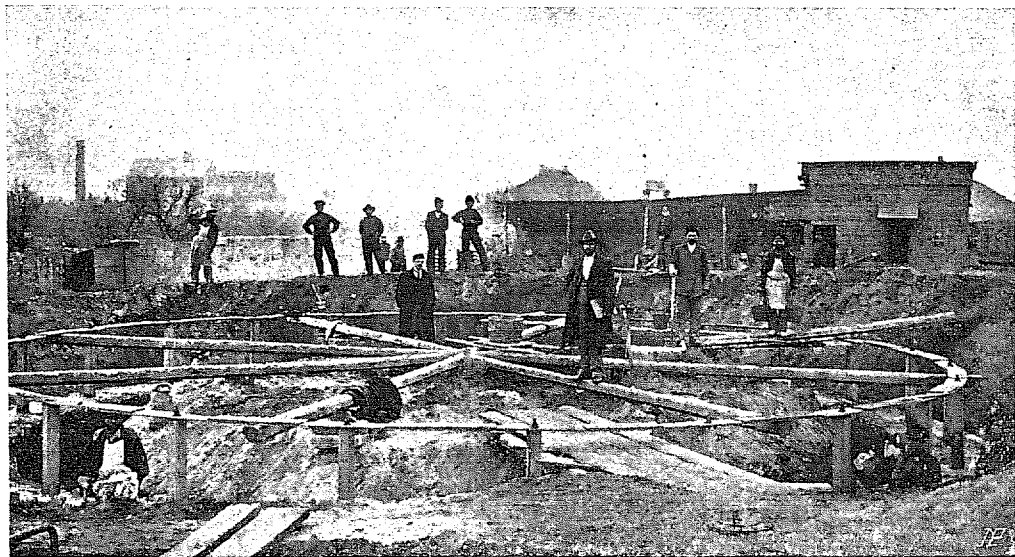
Фиг. 24. Разбивка фундаментного кольца водонапорной башни Николаевского городского водопровода. 1906 г.
