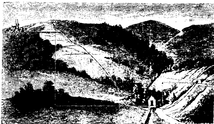
Рис. 72. Водоснабженіе съ помощью тарана.
