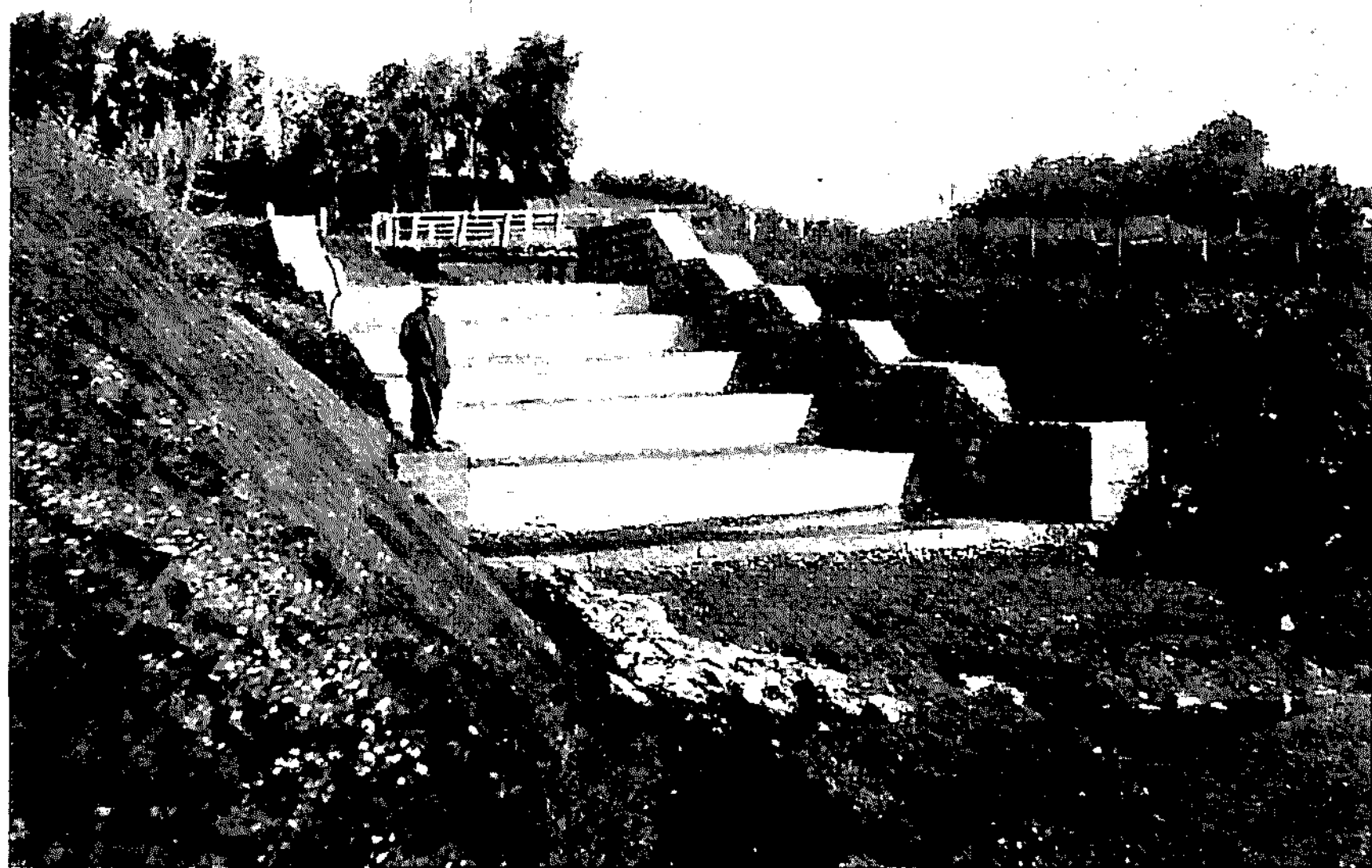
4. Каменно-бетонный водосливъ съ перепадами.
