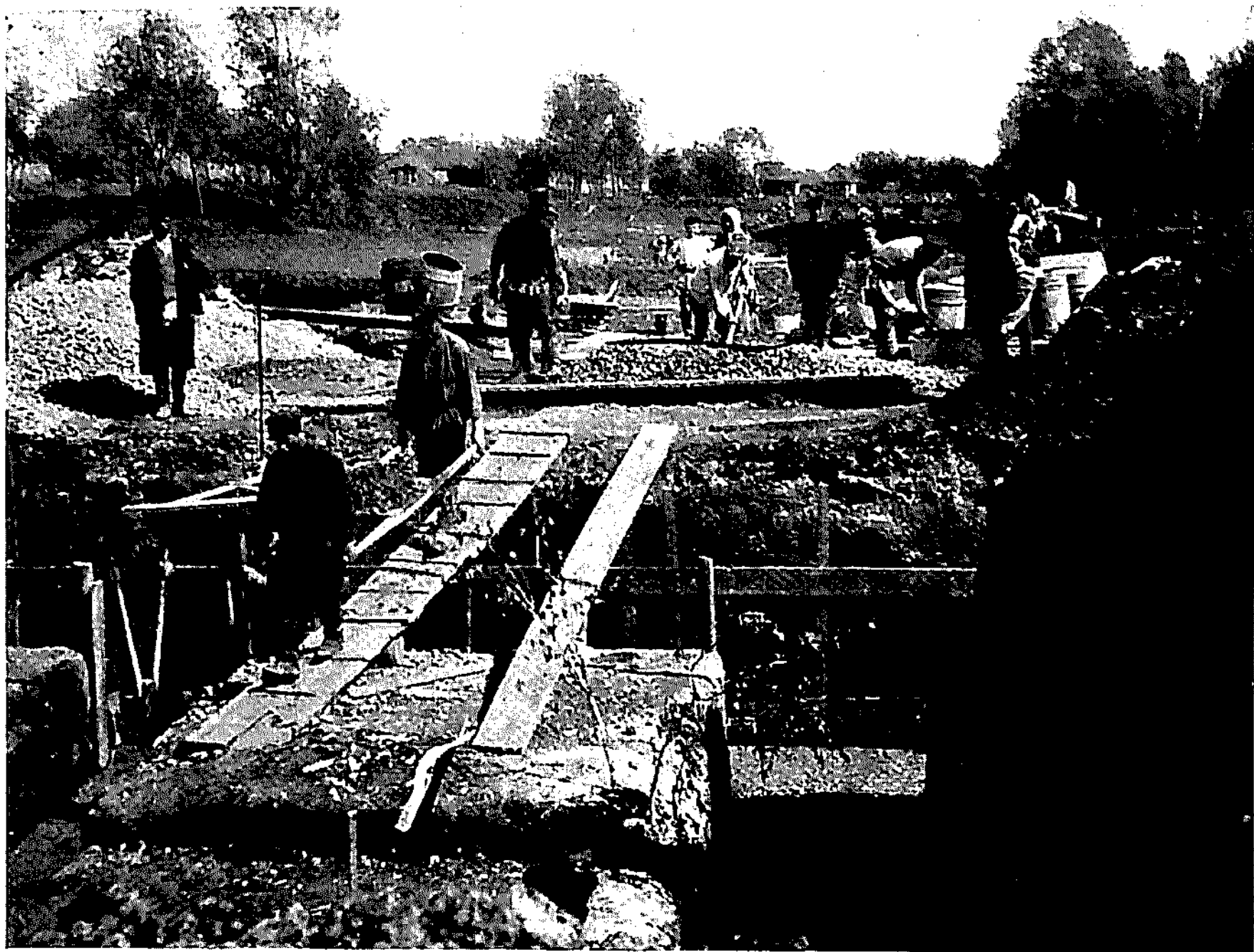
1. Производство бетонных работ.
