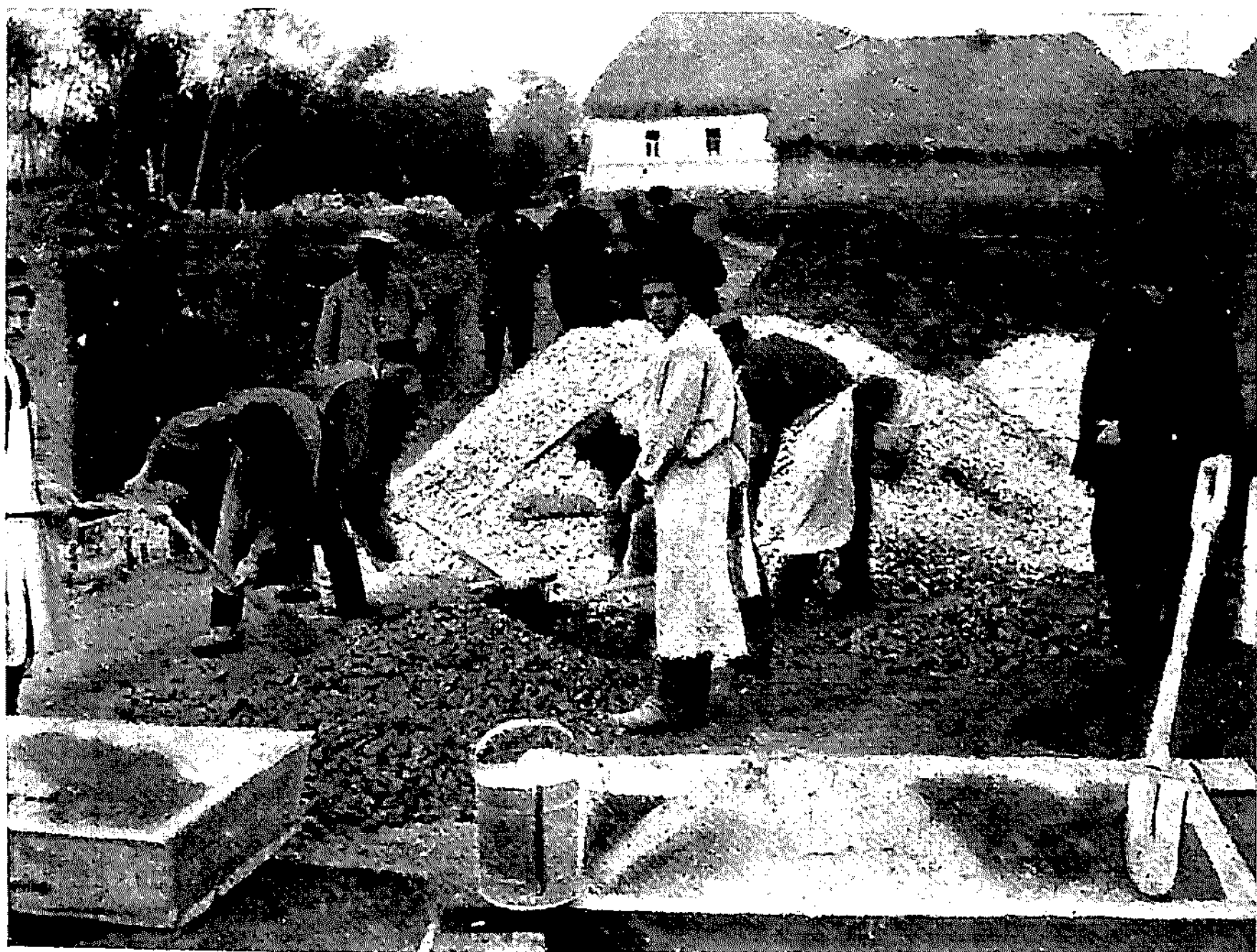
2. Изготовление бетона.
