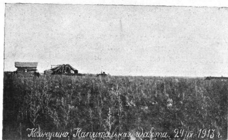
1. Кольчугинский рудник А. О. К. К. К. Сентябрь 1913 г. Начало углубления „Капитальной“ шахты.
