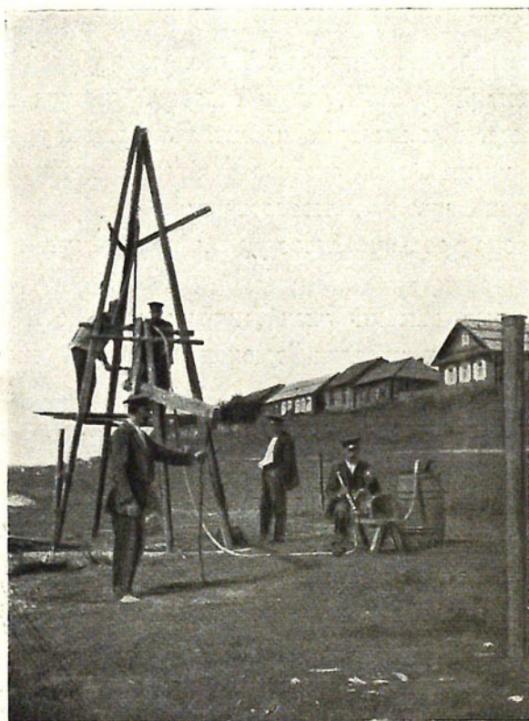
Рис. 9. Буреніе на р. Зап. Двиґъ въ 1913 г. съ промываніемъ скважины.
