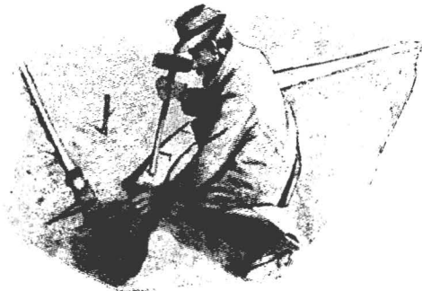
Рис. 48. Выкладываніе края дорожки кирпичами.
