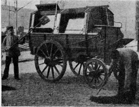
Черт. 16.—Общій видъ мусороотвозной повозки системы «Salubrita».
