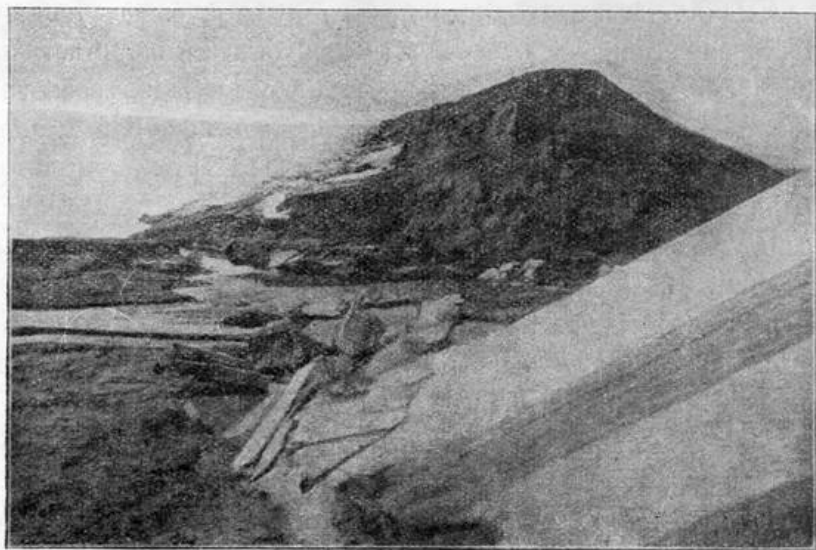
Черт. 255. Видъ плотины въ Horse Creek (С. Ам. С. Ш.) изъ земли съ бетонной одеждой внутренняго откоса послѣ ея разрушенія (см. стр. 301).
